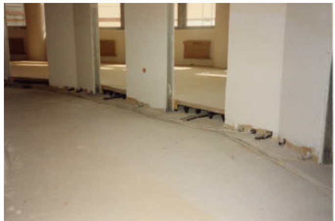
Die Wände zum Flur stehen auf der Rohdecke, die Trennwände, auf dem Bild fehlen sie noch, auf dem Hohlraumboden.
