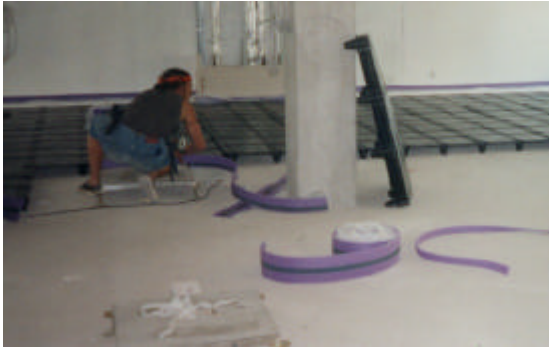
Verlegung der 3S Plus Elemente
