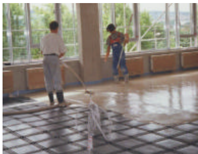
Einbringen des Calziumsulfatestrichs
