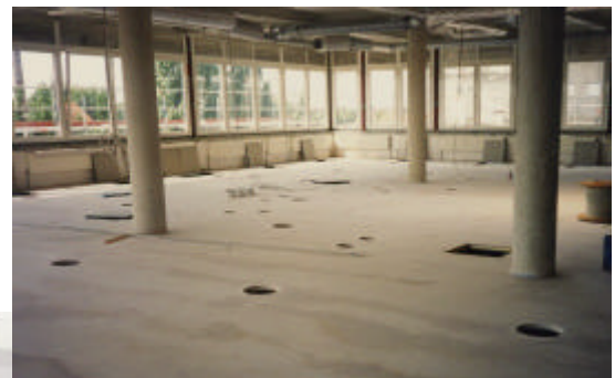
Fertige Fläche mit Öffnungen für Elektrannten
