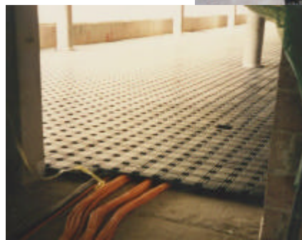
Verlegte 3S Elemente fertig zum gießen des Estrichs
